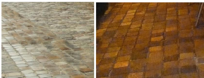
**Illustration de la répartition hétérogène des éclairages verticaux en traversée de rue entre 2 luminaires consécutifs** : rendu diurne (photo de gauche) et rendu nocturne (photo de droite - source à faible restitution des couleurs) d'un même pavage sur le même site
